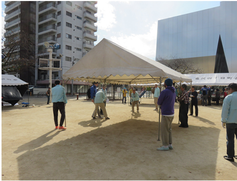
亀沢全町会・全関係者(テント設営)
